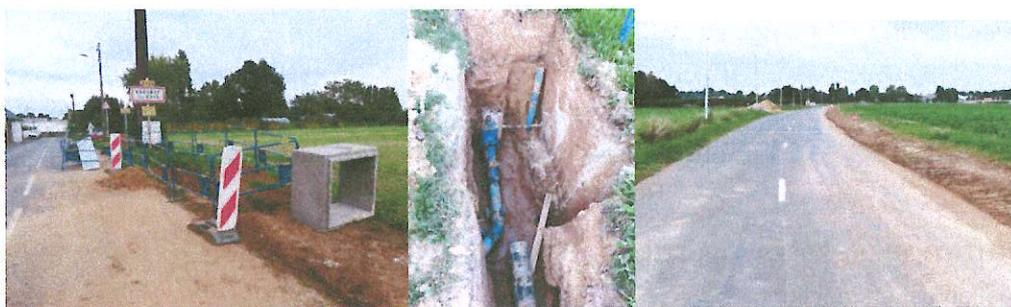
Travaux Faverolles : Remplacement des conduites vieillissantes DN100 et DN 150 mm par une fonte DN150 sur 837 ml avec reprise des 49 branchements, raccordement sur té face mairie et sur té face petite rue : 347 606€ HT €
