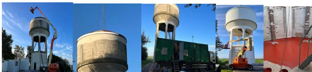
Les travaux sont en cours : peinture extérieure (dôme, cuve extérieure, décapage cuve intérieure) et démontage tuyaux extérieurs.
